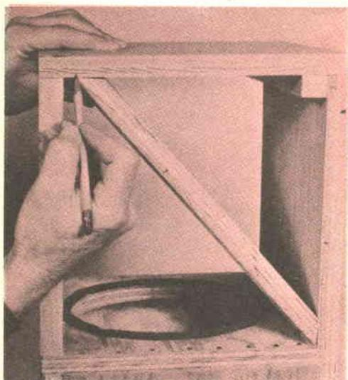
ficie esterna. Quindi, si cosparga abbondantemente di colla una superficie di una traversina di pino e la si inchiodi al pannello, con il suo bordo superiore a livello della linea interna.
