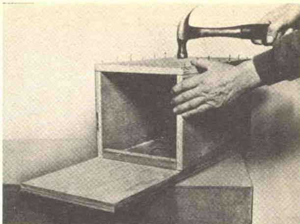
*Fig. 3 - Sistemato provvisoriamente il pannello superiore al suo posto, si tracci una linea nel punto in cui viene a combaciare con il riflettore.*
